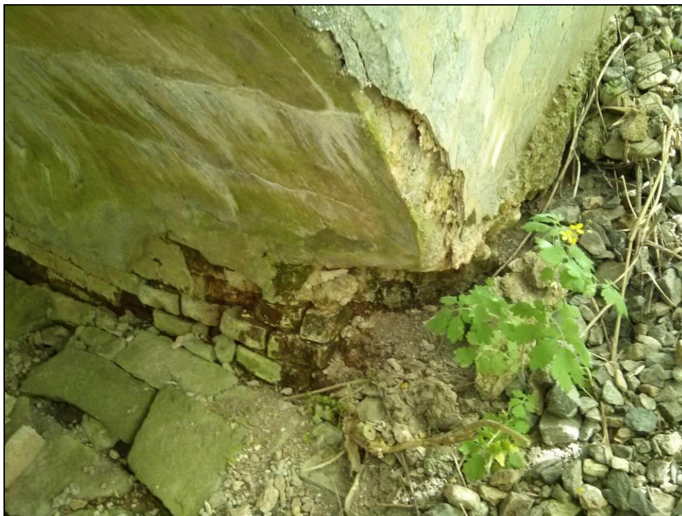
Obr. č. 6 - detail nároží pravé části opěry Znojmo - opady lícového cihelné zdivo do hl. cca 30 cm.
