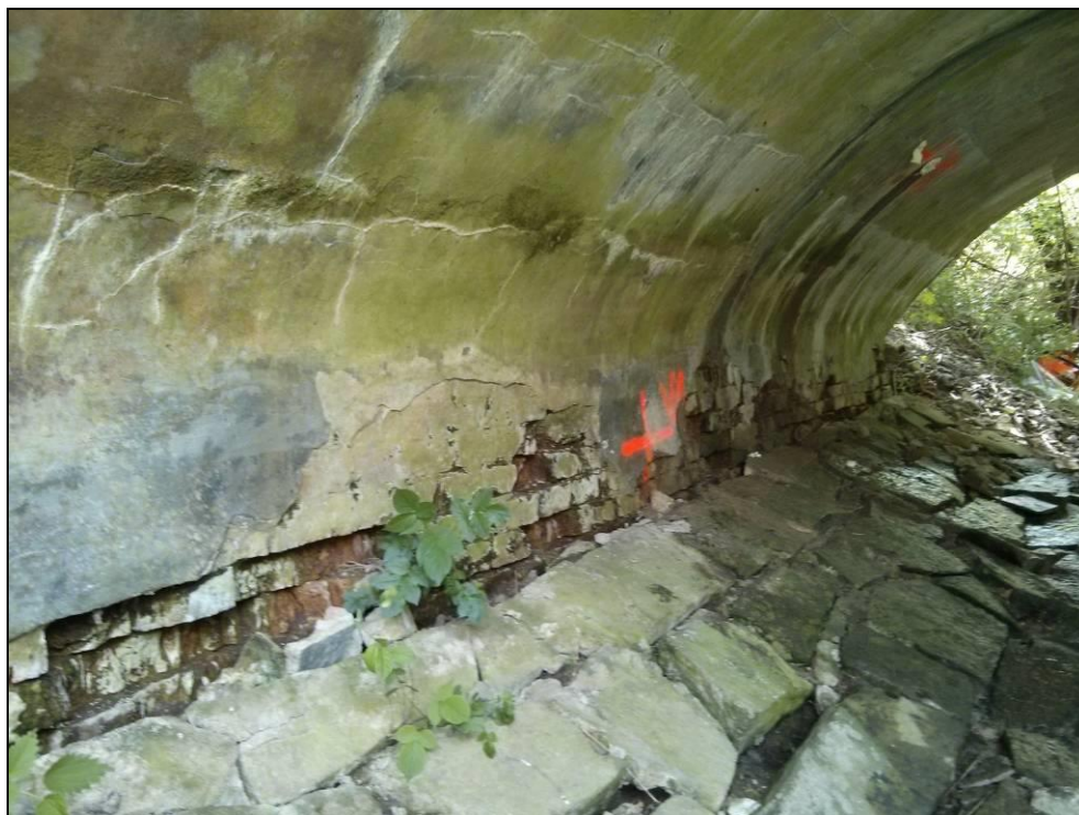
Obr. č. 5 - pohled na degradované lícové cihelné zdivo SS opěry Břeclav.
